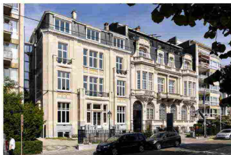
Maison Dewin, sede Delen Private Bank, Bruxelles ("Ex istituto per il trattamento delle malattie degli occhi del dottor Coppez").
